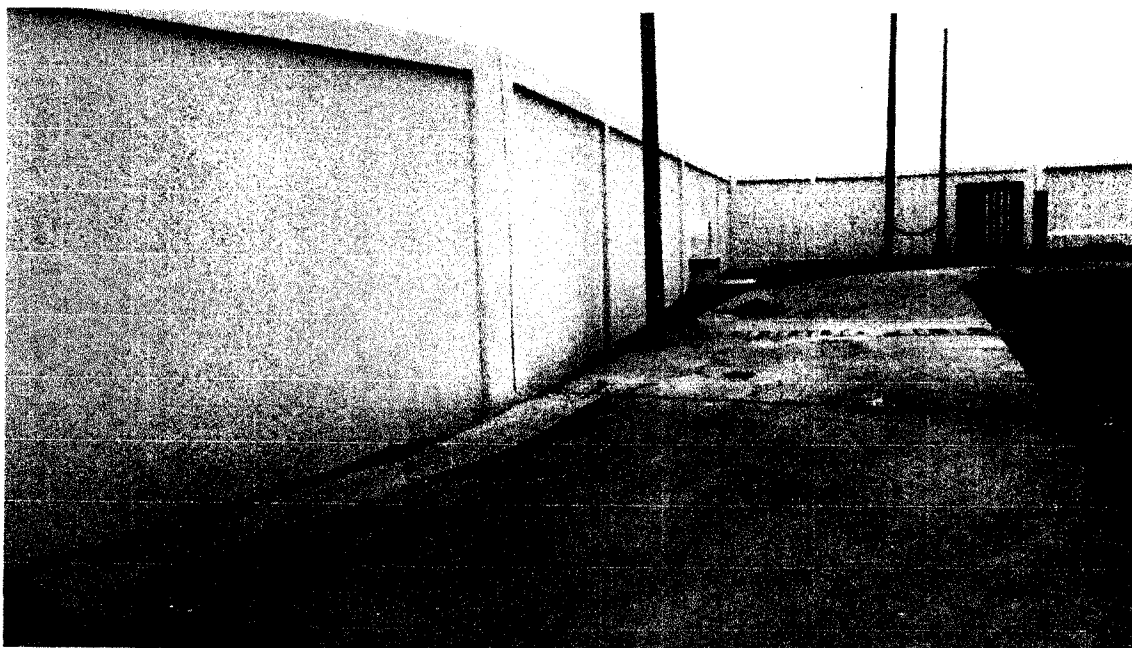
FOTOGRAFIA Nº10. LIMPIEZA FINAL, PINTADO DE MURO EN TRAMO 3, REUBICACION DE CAPILLA.
