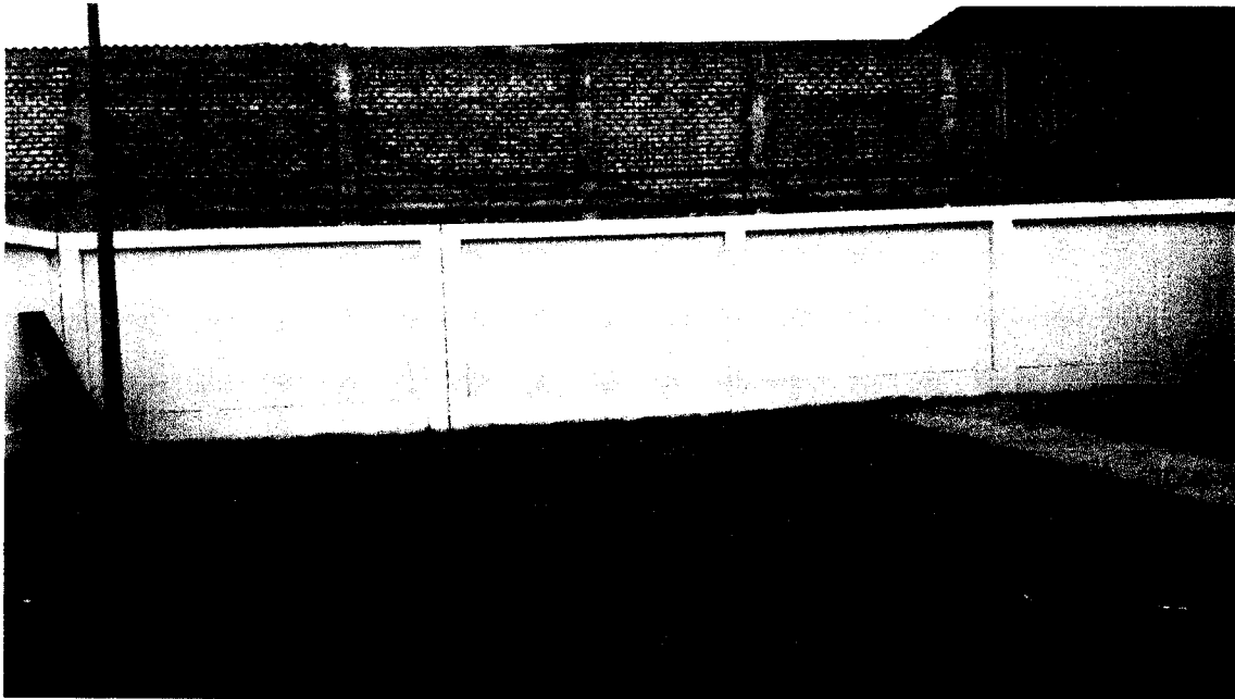
FOTOGRAFIA Nº04. PINTADO DE MURO INTERIOR DE TRAMO 2, ADEMAS SE PUEDE APRECIAR LA LIMPIEZA FINAL DEL ESTABLECIMIENTO DEL DESEMBARCADERO.
